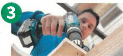
Löcher für Holzschrauben markieren und vorbohren
